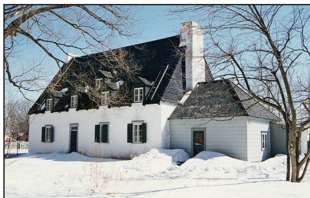
Façade nord de la maison des Jésuites, de tradition rurale française. (Photo Denis Poussart 2003)
