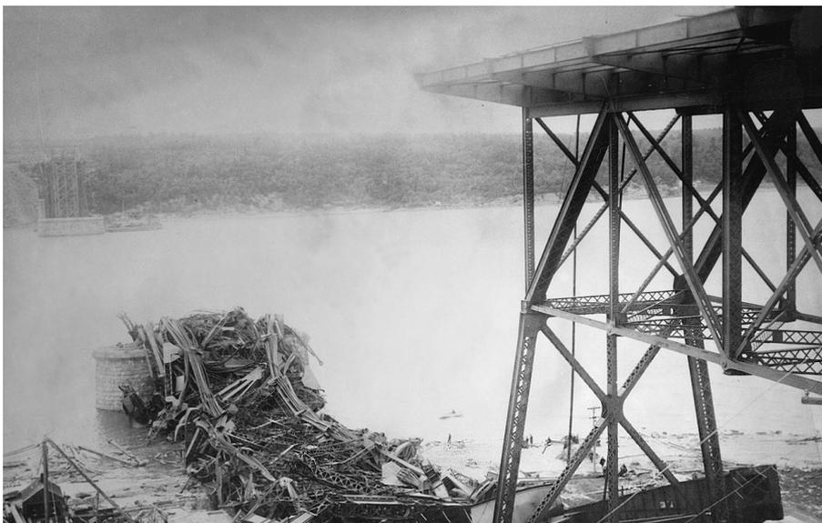
Effondrement de la structure cantilever et d'ancrage du pilier sud
